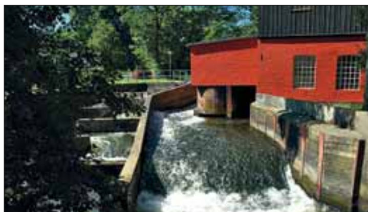
Die Fischtreppe bietet den Fischen die Möglichkeit, die Aufstauung an der Klostermühle zu passieren.
