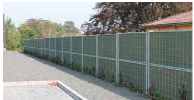
Er der behov for støjafskærmning mod naboer kan den f.eks. udføres som et lydhegn, der med tiden dækkes af klatreplanter. Foto: GinnerupArkitekter.
