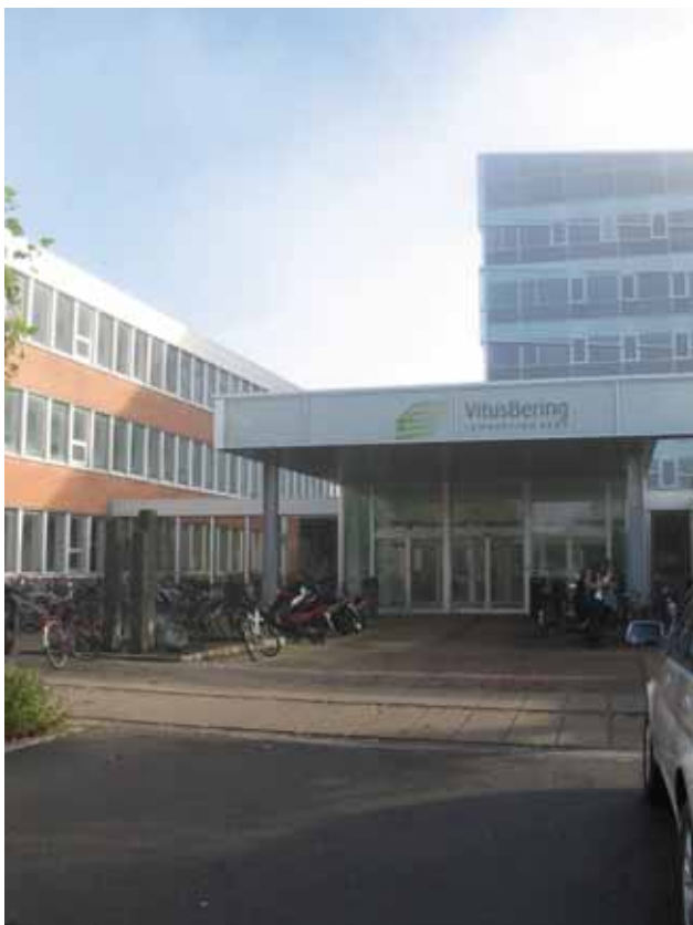
Hovedindgang med væksthuset i baggrunden Foto: Horsens Kommune
