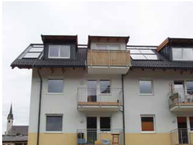
Et eksempel på dårlig integration. Foto: Horsens Kommune
