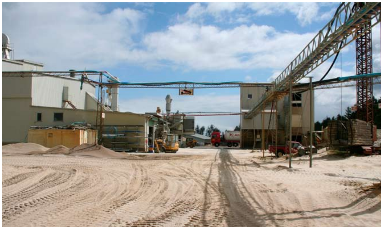
Eksisterende vaskeri til højre og tørreri til venstre
