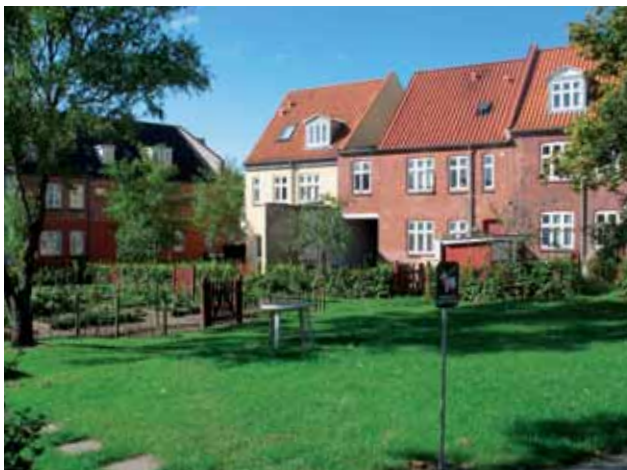
I karréens sydlige og nordlige del er gennemført omfattende byfornyelse.
