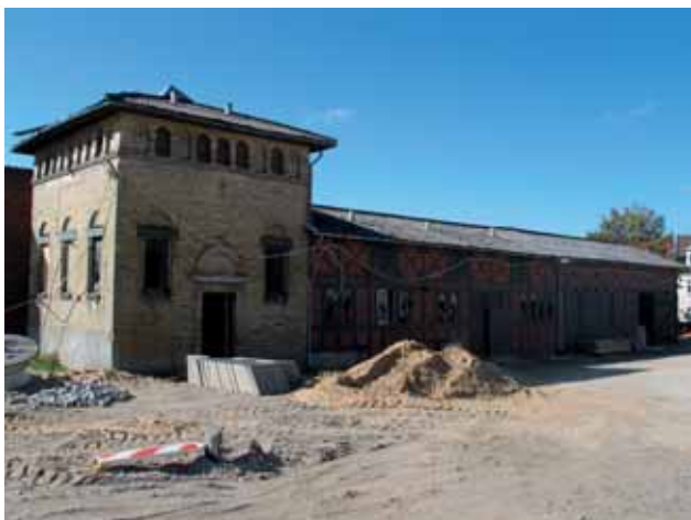
Det gamle vandværk og staldbygningen bevares og anvendes til parkering, værksted eller lignende.
