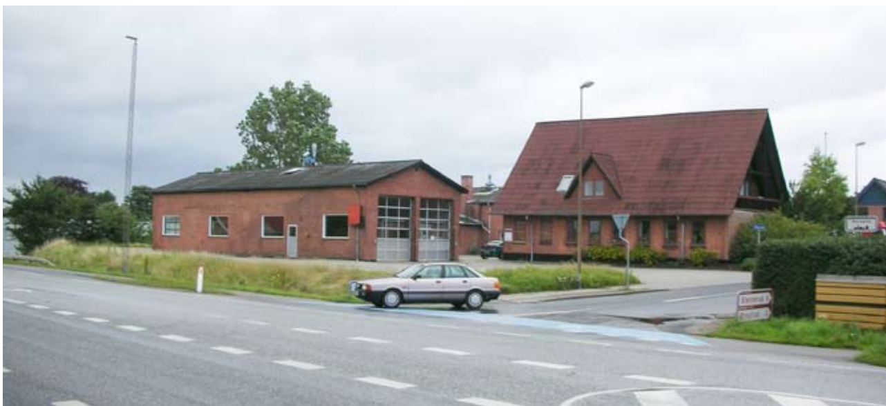
Lokalplanområdet set fra Vejlevej Foto: Horsens Kommune
