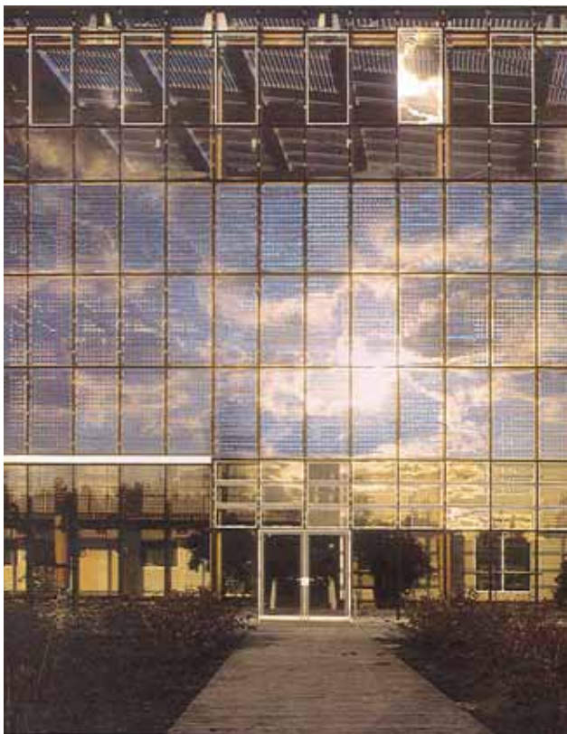
Solceller placeret i glasfacaden. Mont-Cernis centret, Herne, Tyskland Foto: Jens True
