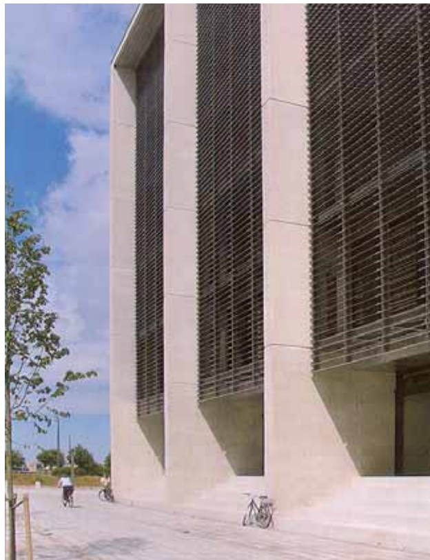
Solceller placeret på lameller foran glasfacaden. Københavns Energis domicil - Ørestaden. Foto: Karin Kappel
