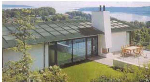
Eksempler på bygningsintegrerede solceller.
