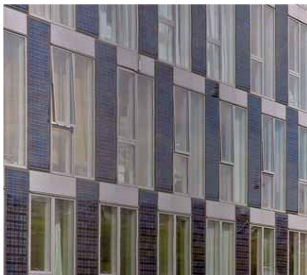
Solceller placeret i felter i facaden. Ungdomsboliger på Silkeborgvej i Århus Foto: Jørgen Jørgensen
