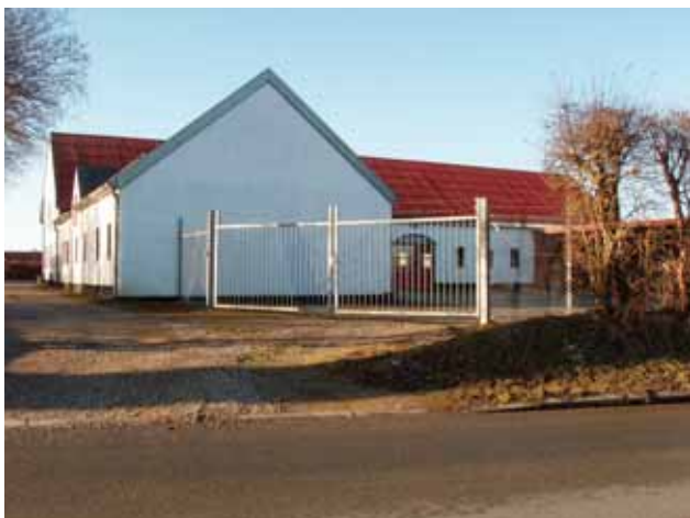
Eksisterende ejendom på Matr. 8t set fra Ørridslevvej. Ejendommen nedrives
