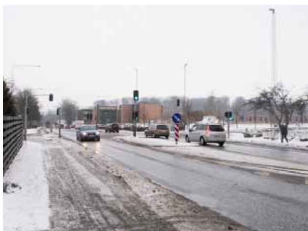
Kontorbebyggelsen set fra krydset mellem Schüttesvej og Lovbyvej. I forgrunden ses støjvolden
